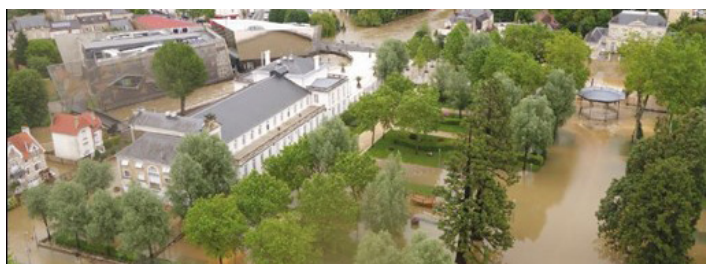
Inondations à Montargis en juin 2016 - ©EPAGE du bassin du Loing
