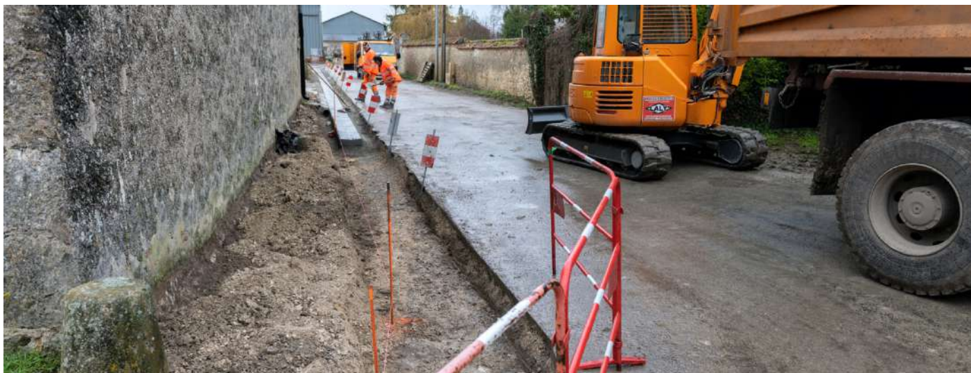
Travaux rue des Fossés Nord
