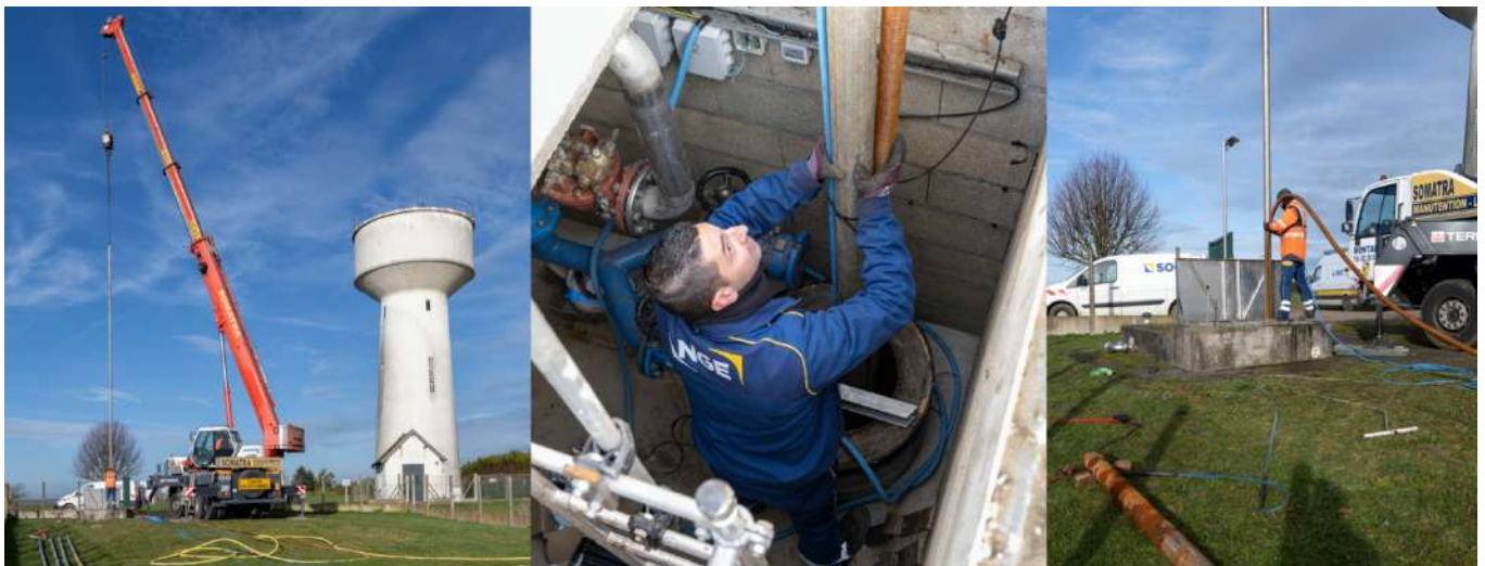
Changement de la deuxième pompe qui présentait quelques faiblesses, le 19 janvier 2021
